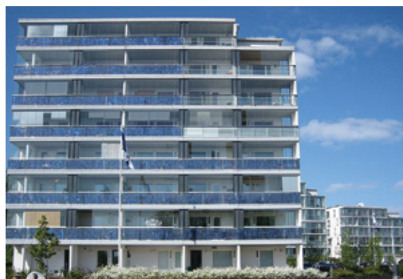
Мал. 3.2.12. Віікі – квартал будынкаў з нізкімі эаэгаэвыдаткамі ў Хельсінкі (Фінляндыя). У фасад убудаваны панэлі, якія акумуляюць сонечную энергію.
