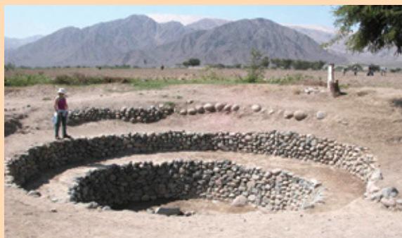
Мал. 2.4.10. Сістэма збору вады ў Наска (паўднёвае ўзбярэжжа Перу) для падземных акведукаў і падачы ў пласты грунтавых вод.
