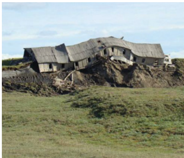
Мал. 2.8.9. Будынак вайскай часці, разбураны з прычыны нераўнамернага пучэння і прасадак.
